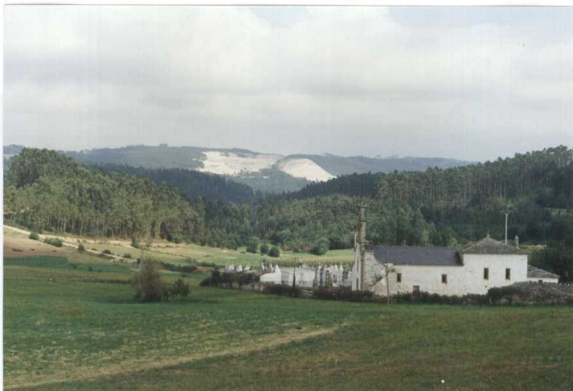
Foto nº 11: Vista panorámica de una de las dos canteras de caolín, de Foz, con las escombreras adosadas a la corta.
