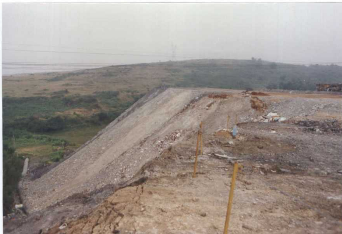
Foto N o 13: Detalle de talud de escombrera de finos de magnesita calcinada, situada a pié de fábrica.
