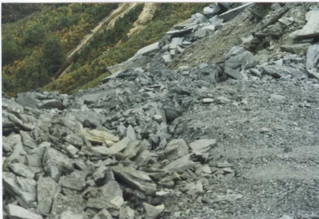
FOTO N° 7: Detalle de inestabilidades en el borde de escombrera de pizarras ornamentales, así como de granulometría de los materiales vertidos.
