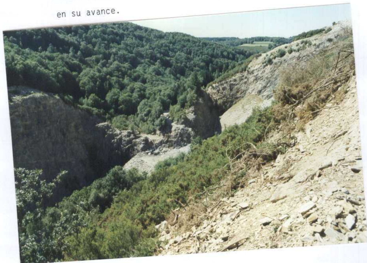
Foto nº 16: Detalle de otro frente con las mismas características que el de la foto anterior, correspondiente a la explotación de Europizarras, S.A. en la zona de Los Oscos.
