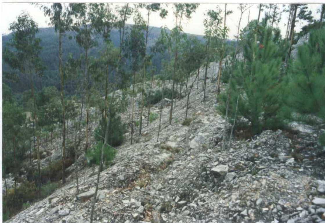
FOTO N° 9: Detalle de hundimientos escalonados y abombamientos, en el talud de una escombrera de caolín. También es notoria la revegetación practicada.
